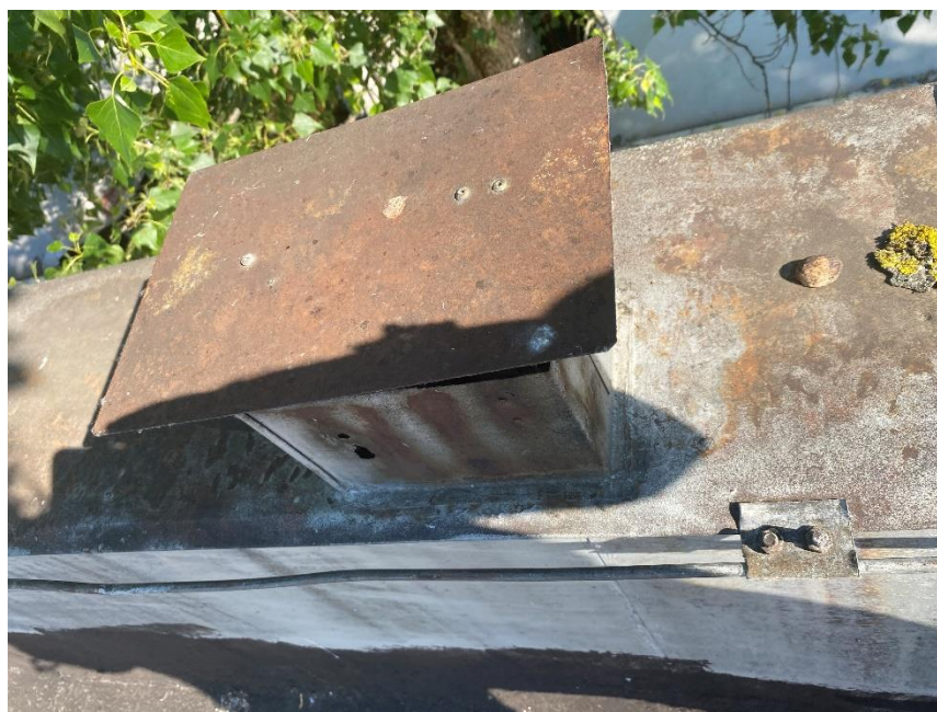
Obr. č. 3 Odvetranie na atike – 2 ks (odstrániť)
