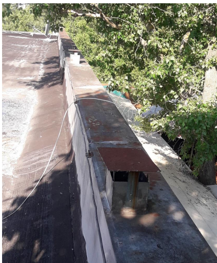
Obr. č. 4 Odvetranie na atike – 2 ks (odstrániť)
